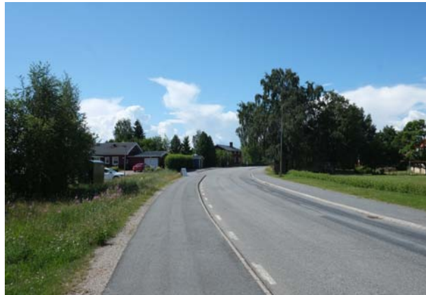
Landsväg 855 samt gång- och cykelväg.
