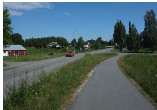
6. Knutpunkt vid trevägs korsningen samt gång- och cykelvägen.
